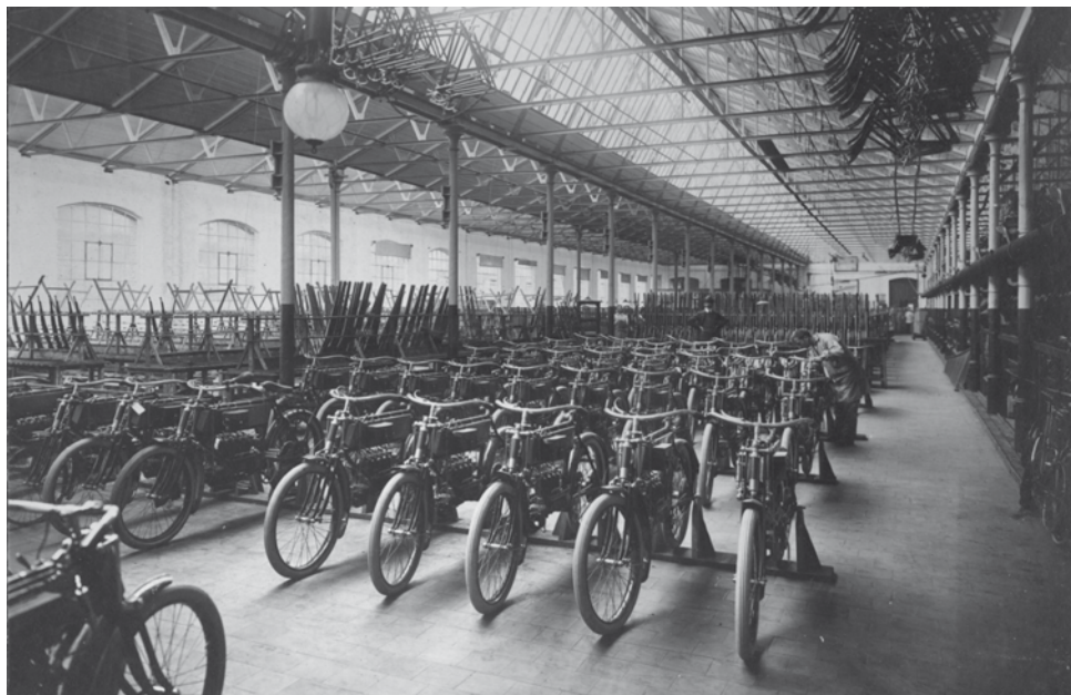
Construction de motocyclettes à la F.N. Herstal
