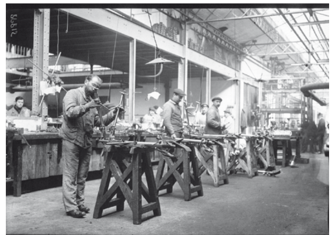
Fabrication des mitrailleuses à l'usine Darracq, Suresnes, France, 1915
