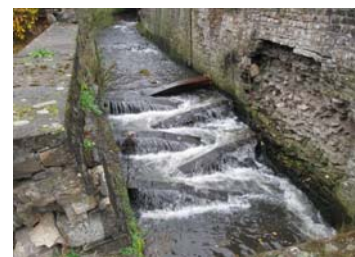
Défecteurs pour la libre circulation des poissons
