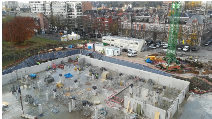
LIEGE – Exécution du sous-sol
