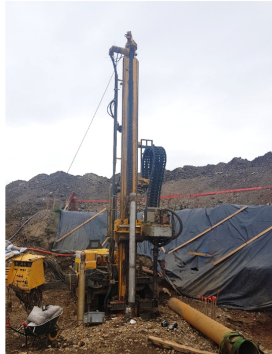
LIEGE – Réalisation des forages géothermiques
