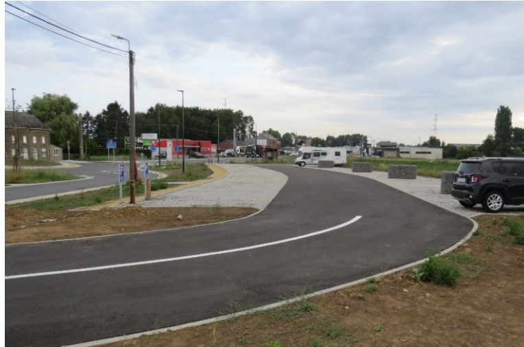
NANDRIN – Site de la rue Famioul - Vue générale du parking d'EcoVoiturage
