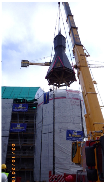
AMAY - Pose d'une tour au Château de Jehay
