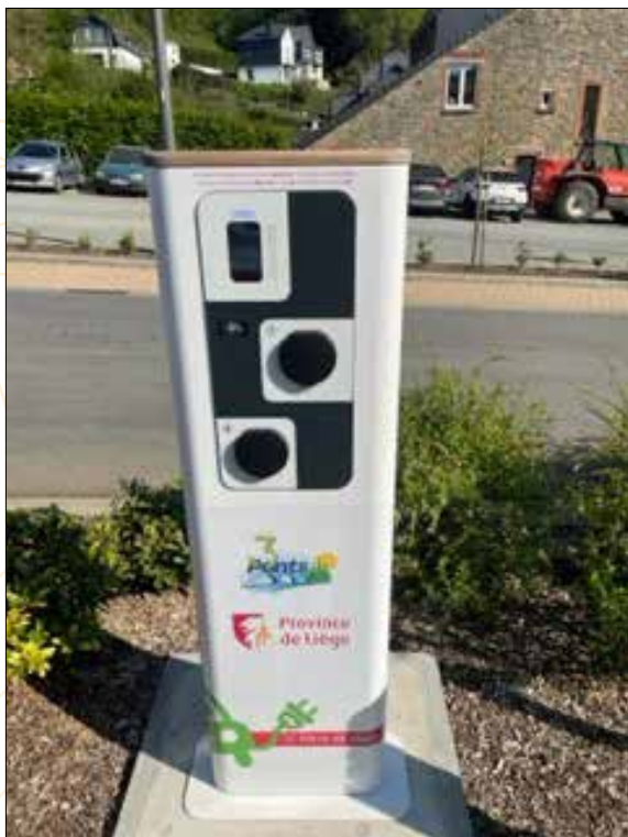
Borne de rechargement provinciale
