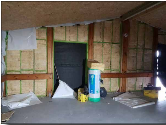
Isolation d'un mur en cours
