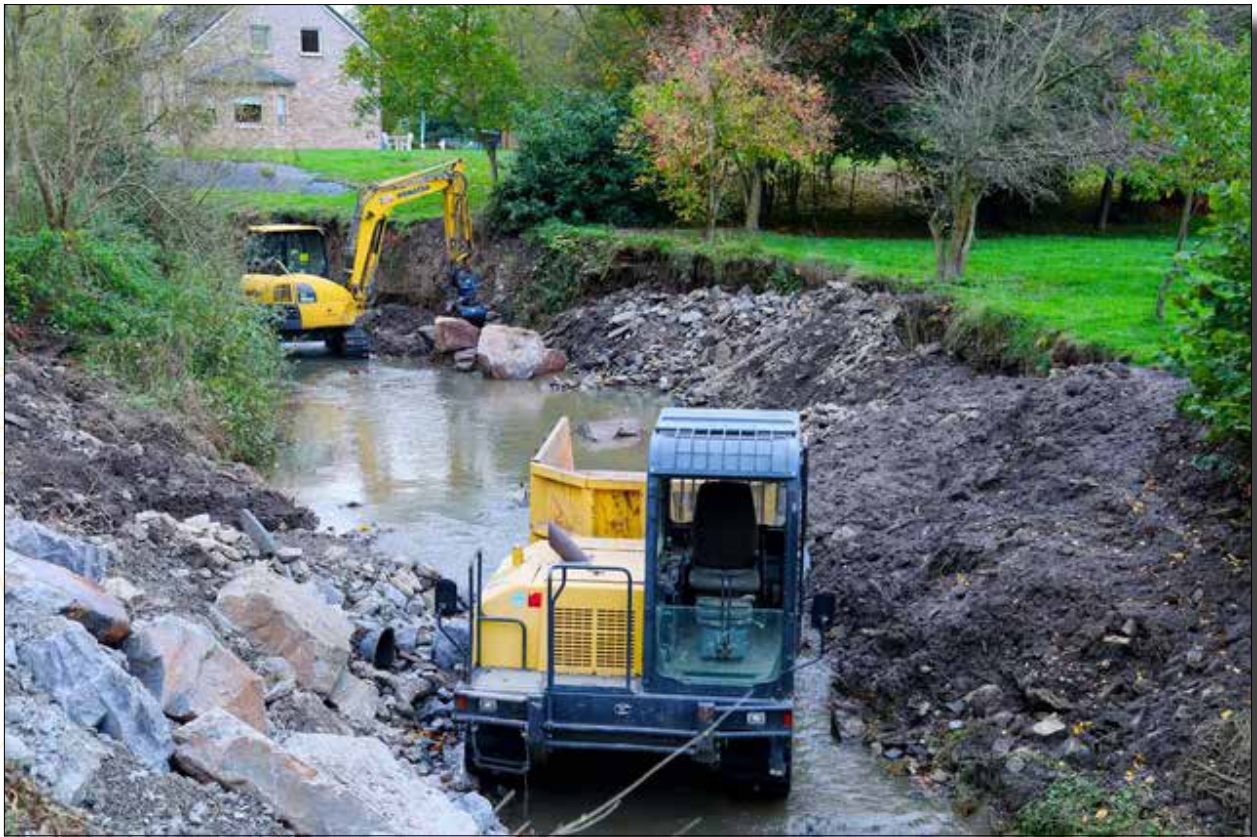
Enlèvement et évacuation de sédiment et reconstruction de berges à Trooz
