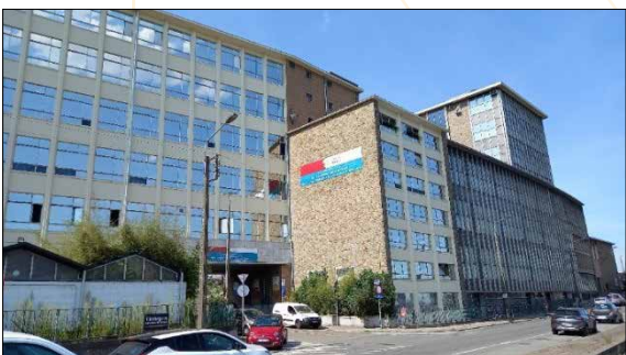
Rénovation de la façade à Herstal
