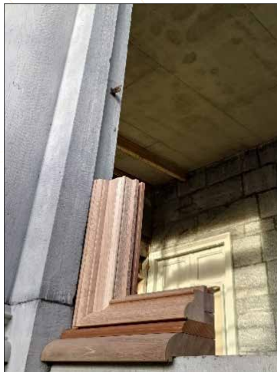
Château de Jehay – Restauration de la galerie Balat : création de gabarits pour les menuiseries
