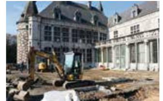
Die entsprechenden Vorbereitungsarbeiten sind bereits seit Oktober im Gange. Auch hier gibt es zwei Etappen: Zum einen wurde ein Gerüst entlang der Schlossfassade errichtet, an der Seite des Wassergrabens. Zum anderen wurde die Deckplatte abgerissen, die Stollen aufgefüllt und eine neue Deckplatte angebracht, im Hinblick auf die Schaffung eines Baustellenbereichs; hier wird ein Turmdrehkran aufgestellt. Die Provinz übernimmt den Gesamtbetrag der Vorarbeiten, insgesamt 886.201,58 € inkl. MwSt.
